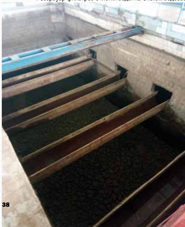
Резервуар фильтров очистки воды на Окском водозаборе: до и после обработки материалом «ПенеПокси 2К»
