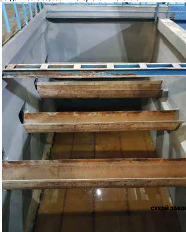
Резервуар фильтров очистки воды на Окском водозаборе: до и после обработки материалом «ПенеПокси 2К»
