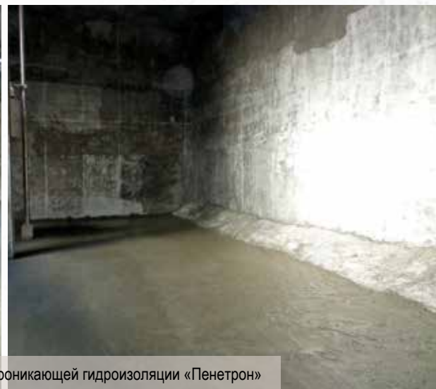
Биореакторы SBR после завершения монолитных работ
