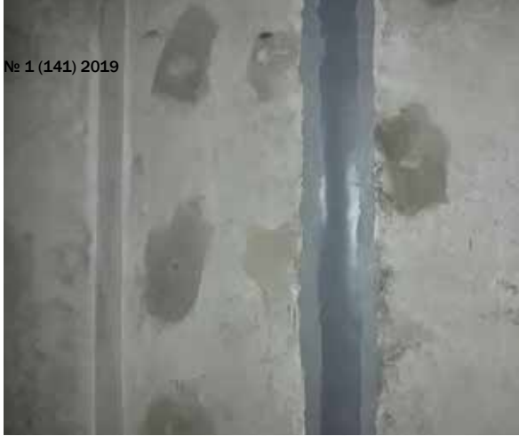
Система Пенебанд С в гидроизоляции температурных швов подвального помещения
