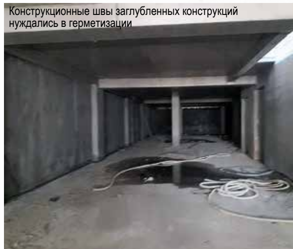
Гидроизоляция выполнена по технологии Пенетрон + Пенекрит
