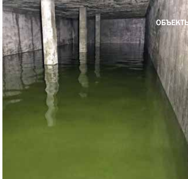
Изъяны гидроизоляции привели к утечке воды из пожарного резервуара
