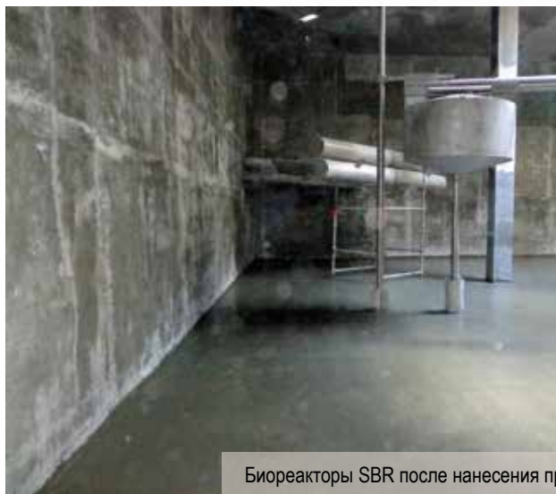
Биореакторы SBR после завершения монолитных работ
