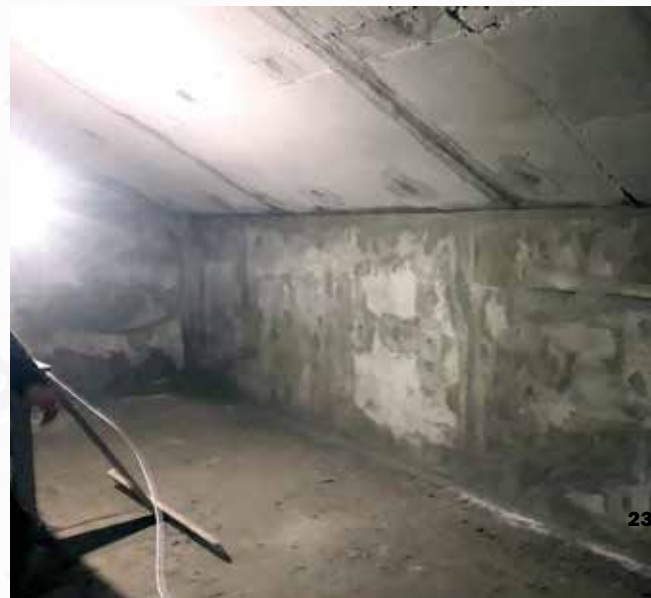
Гидроизоляция выполнена по технологии Пенетрон + Пенекрит
