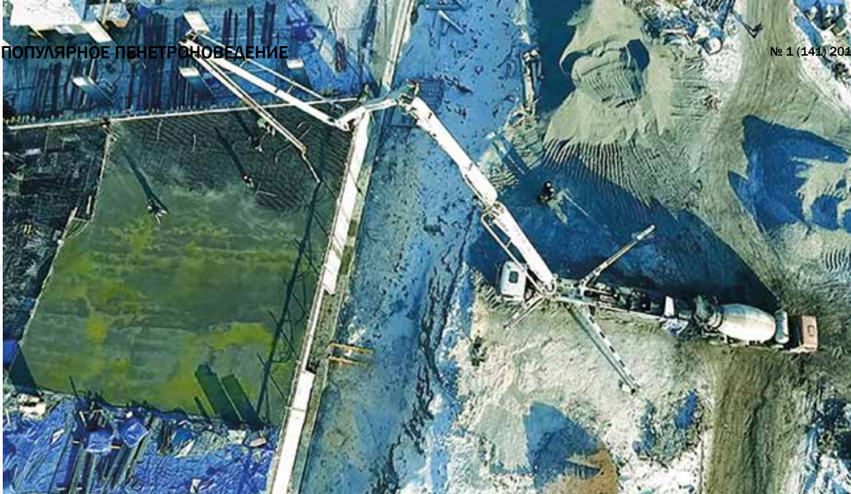
Рис. 1 – Бетонирование фундаментной плиты с добавкой «Пенетрон Адмикс»
