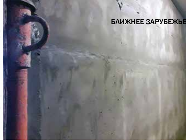
Система Пенебанд С в гидроизоляции температурных швов подвального помещения
