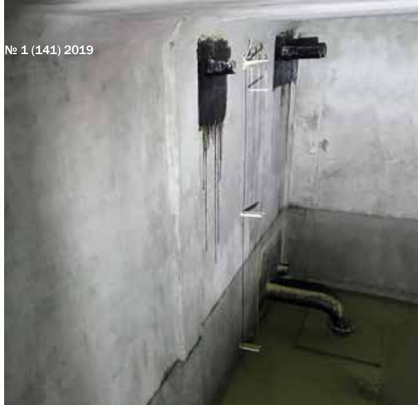
Изъяны гидроизоляции привели к утечке воды из пожарного резервуара
