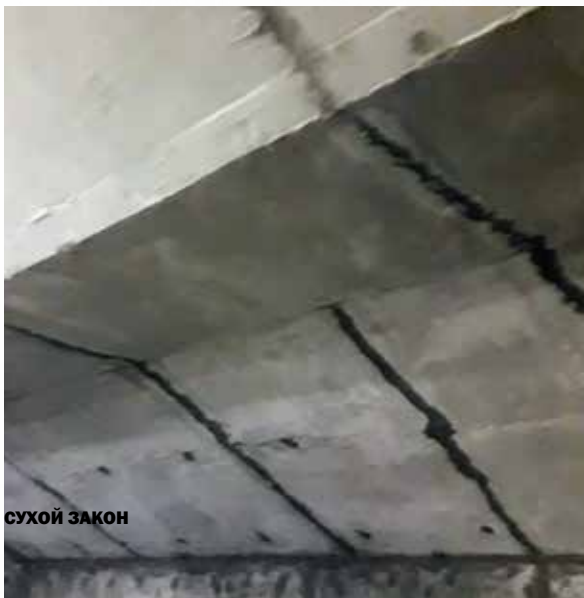
Гидроизоляция выполнена по технологии Пенетрон + Пенекрит
